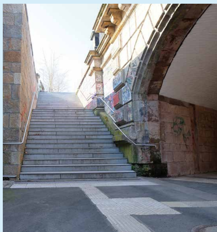
Treppenaufgang zur Dresdner Straße (Quelle: Stadt Chemnitz)
