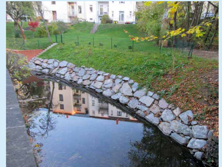
Neuerrichtete Ufermauer am Pleißenbach (Quelle: Stadt Chemnitz)
