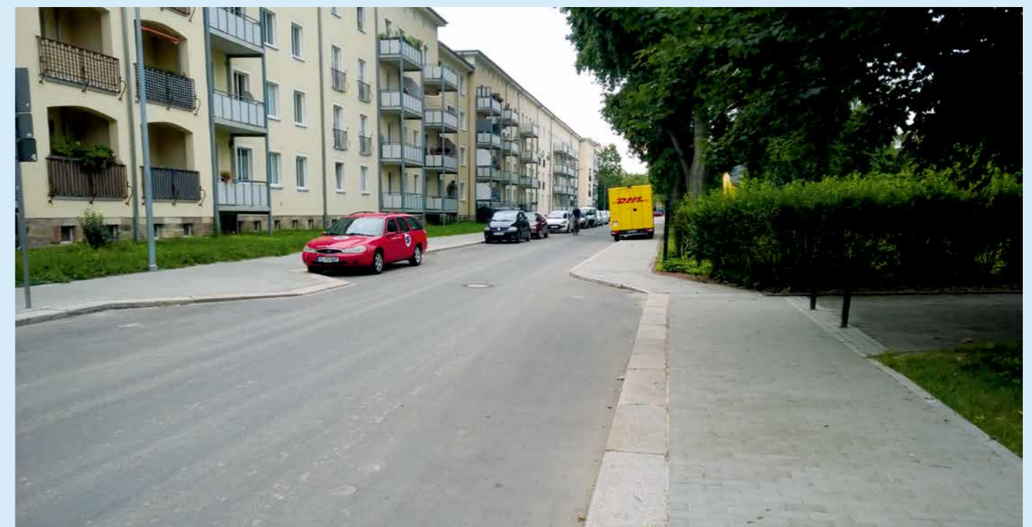
Barrierefreies Gehwegpflaster und abgesenkte Bordsteine der Brauhausstraße (Quelle: Stadt Chemnitz)
