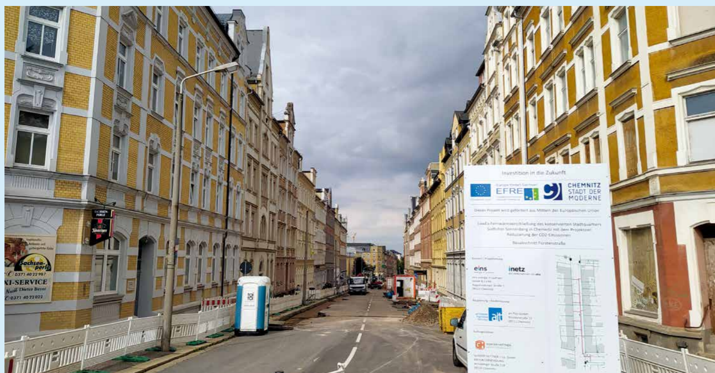
Die Fürstenstraße während der Verlegung der Fernwärmetrasse 2020 (Quelle: Stadt Chemnitz)
