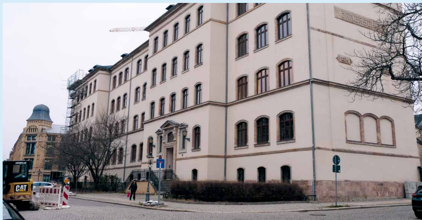
Die Außenansicht der Georg-Weerth-Oberschule Chemnitz – heute Oberschule am Körnerplatz – nach der Sanierung (Quelle: Stadt Chemnitz)
