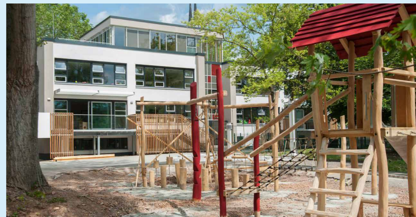
Neubau von Sandkasten, Spielgeräten und Rollbahn im Außengelände der Kita Sonnenstraße 42 (Quelle: Katja Billep Planungsteam)
