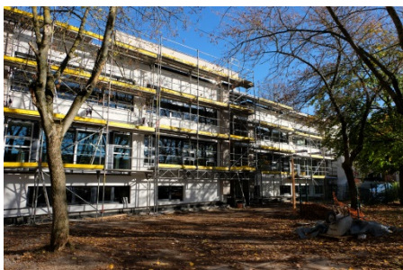
Neue Fassade im Bau
