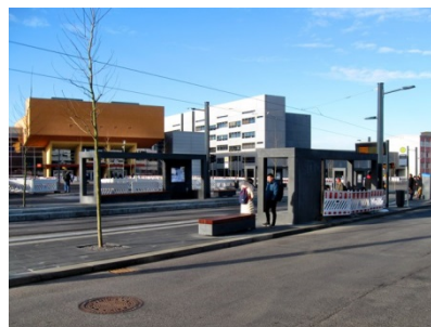
Haltestellenbereich Blick Richtung Nord-West
