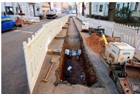
Verlegung eines Abschnittes
