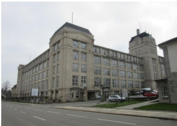
Leerstehende ehem. Industriegebäude
