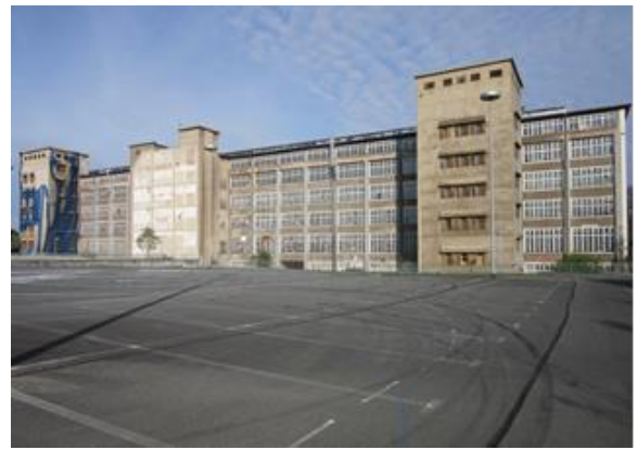
Leerstehende ehem. Industriegebäude
