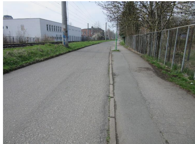
Rad- und Fußweg zur Kita entlang Kappelbach
