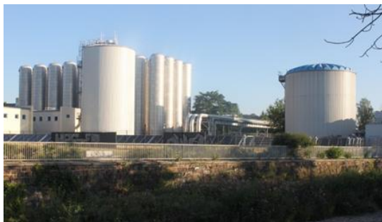
Wärme- und Kältespeicher der eins im LowEx-Fernwärmenetz des Brühl Foto: Stadt Chemnitz
