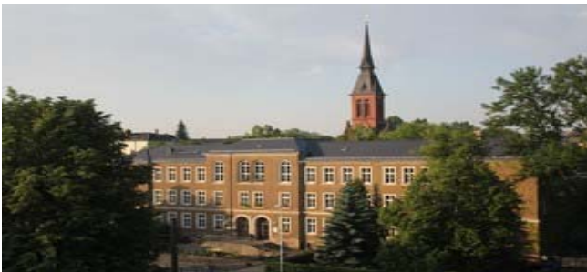
OS Gablenz – Anschaffung mobiler Klassenräume, Planung und Bauausführung
