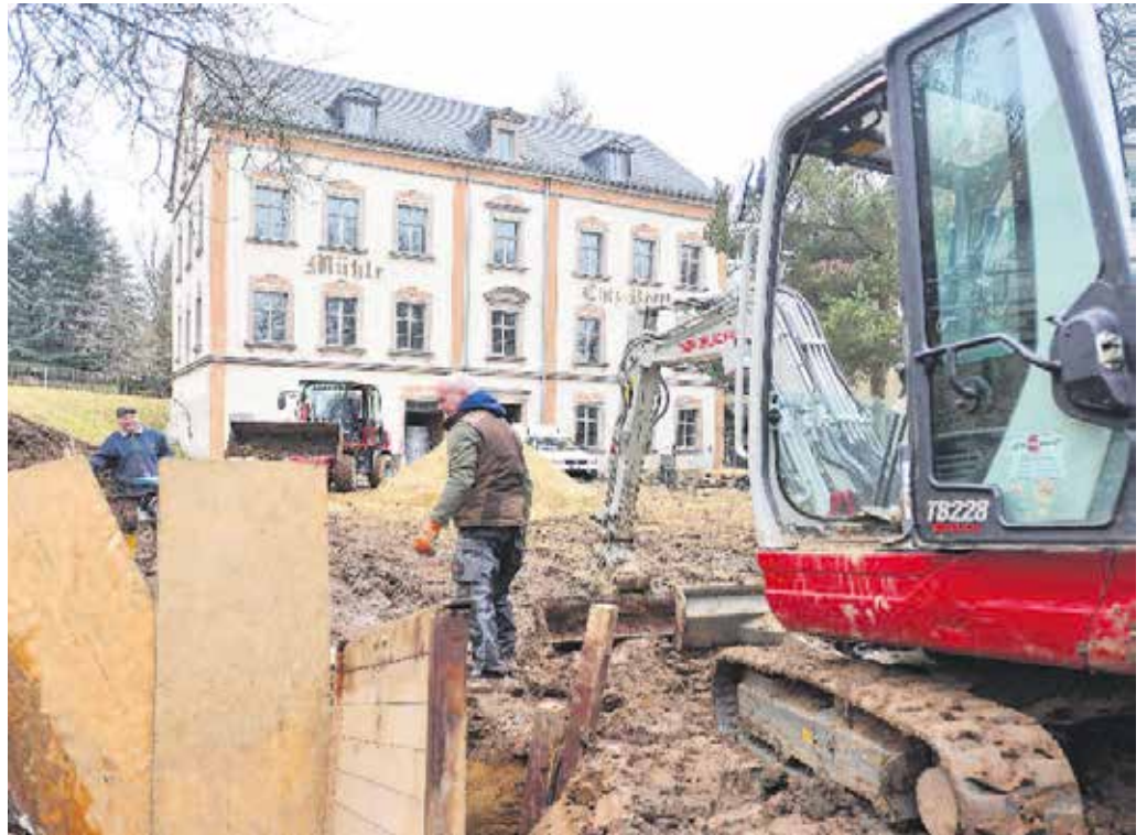
Auf dem Gelände der Rottluffer Mühle tut sich seit Mitte März etwas. Ein Chemnitzer Verein kümmert sich um das Geburtshaus des Malers Karl-Schmidt-Rottluff. Sobald die Ver- und Entsorgungsleitungen verlegt sind, kann die historische Mühlentechnik saniert werden. Foto: Wolfgang Schmidt
