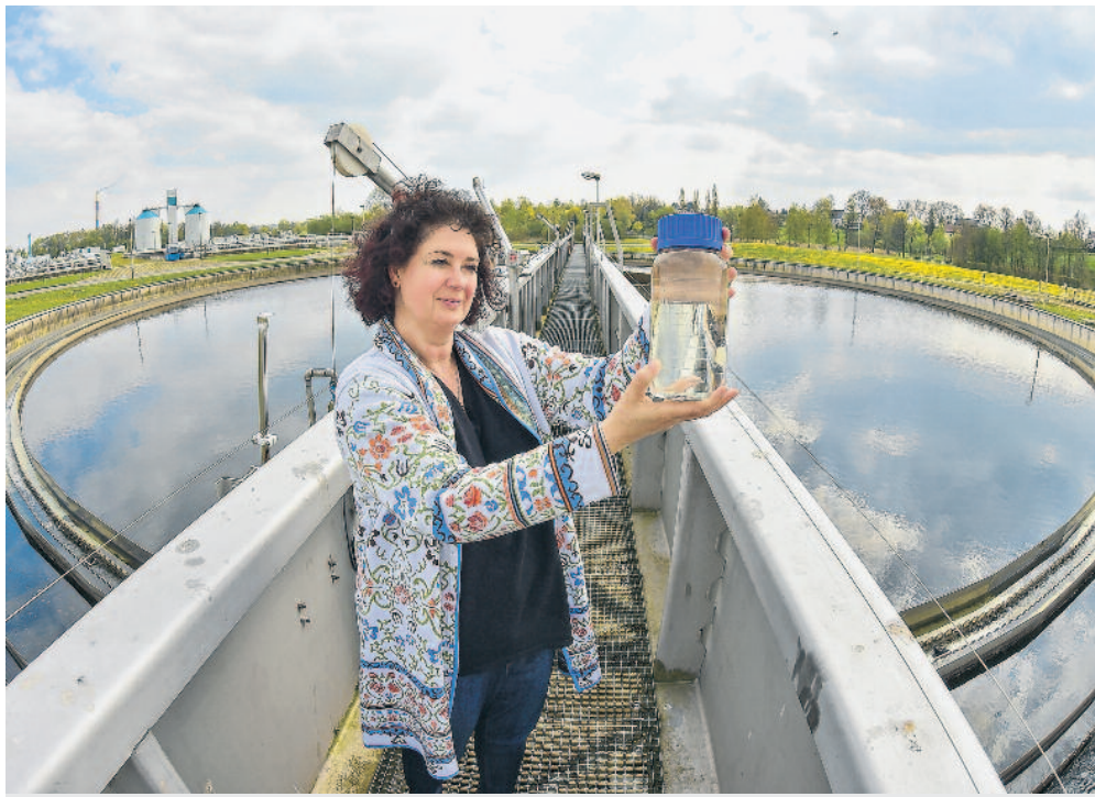
Leitet seit 1992 die Kläranlage: Anne-Kathrin Sundheim
