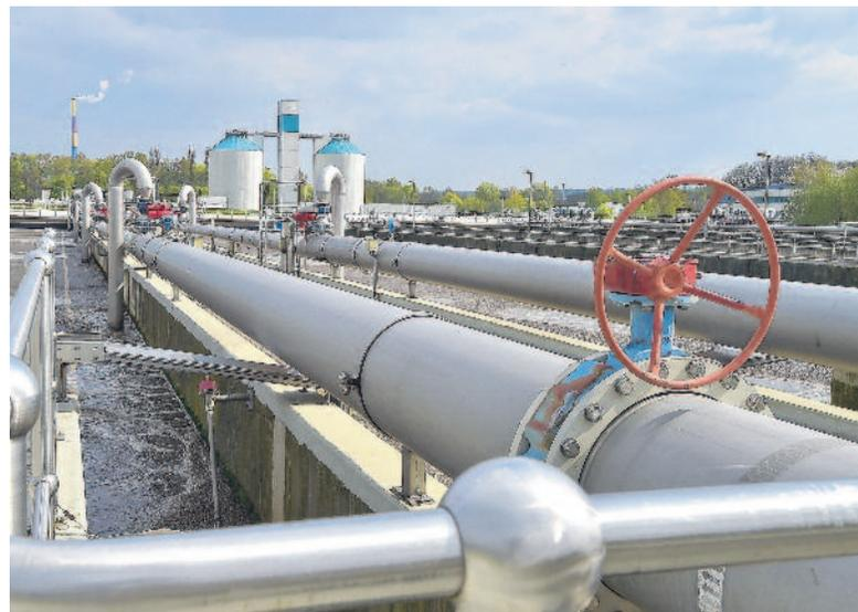
Blick auf die Belebungsbeckenanlage und die zwei 33 Meter hohen Faultbehälter.
