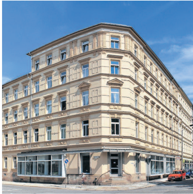
Saniertes Haus an der Georgstraße.
