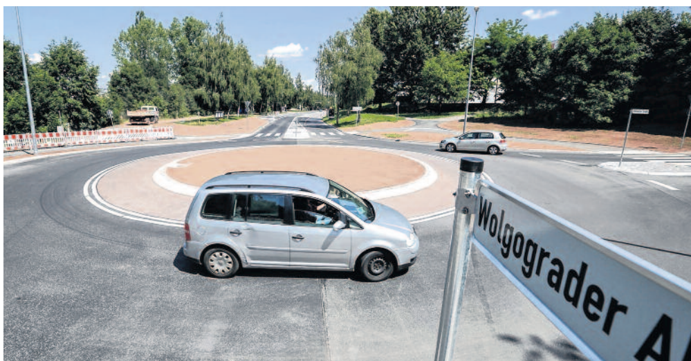
Am 29. Juni wurde der umgebaute Knotenpunkt Wolgograder Allee / Chemnitzer Straße planmäßig für den Verkehr freigegeben. Foto: Toni Söll
