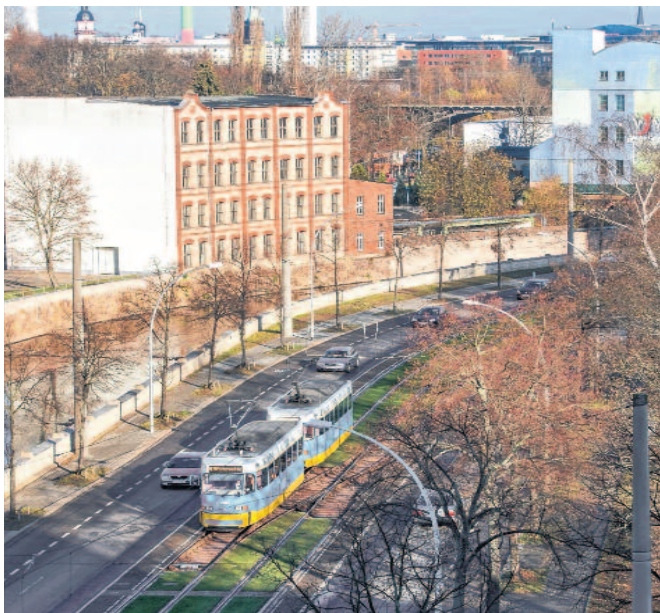
Gleisbauten auf der Annaberger Straße sind beendet. Foto: Kristin Schmidt
