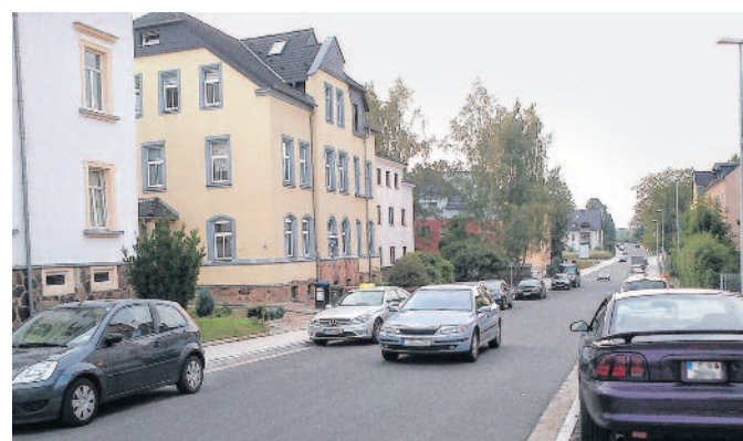
Wittgensdorfer Straße von Grund auf erneuert.
