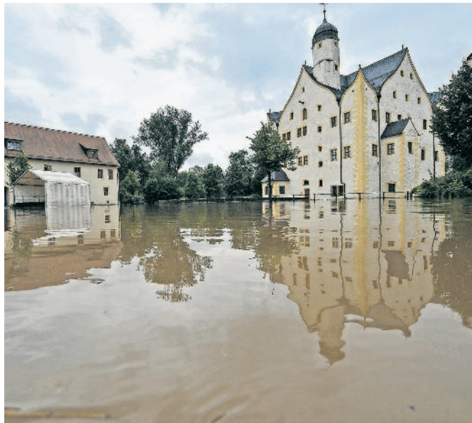
Bei Fluten in den Jahren 2002 und 2010 war auch in Klaffenbach »Land unter«. Der Bau eines neuen Hochwasserrückhaltebeckens in Neuwürschnitz soll mehr Hochwasserschutz bieten. Archivfoto: Wolfgang Schmidt
