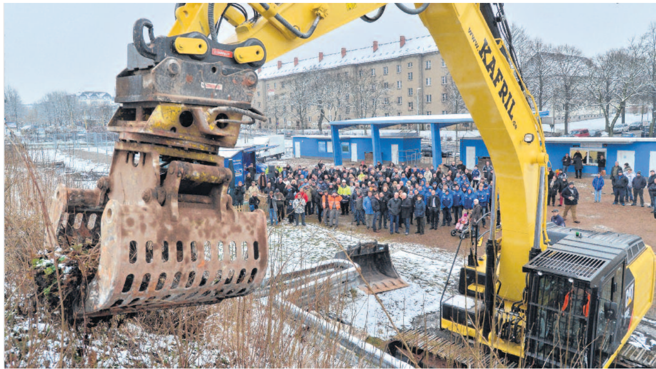
Der Stadionumbau an der Gellertstraße begann am vergangenen Donnerstag mit dem Abbruch der Süd- und Nordtribüne. Das Vorhaben soll bei laufendem Spielbetrieb und mit einem Budget von maximal 25 Millionen Euro erfolgen. Foto: Wolfgang Schmidt
