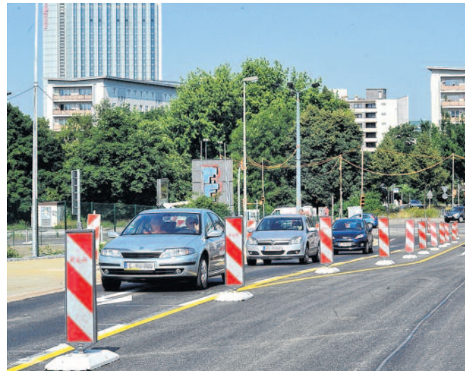
08.07.13: Teilweise Verkehrsfreigabe beim Bauprojekt Dresdner Platz. Foto: Christof Heyden
