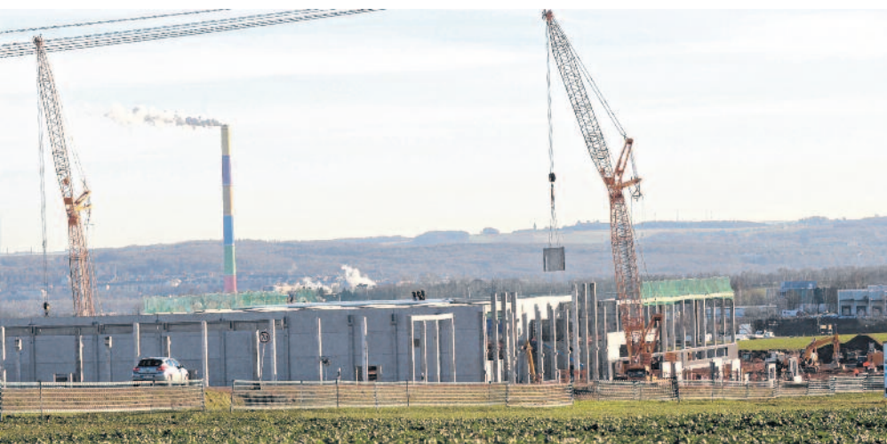
15.10.13: Siemens baut ein neues Werk in Chemnitz: 2014 sollen 600 der insgesamt 1200 Chemnitzer Mitarbeiter in die neuen Gebäude umziehen. Der Stadtrat hatte im Juni den Verkauf einer 80.000 Quadratmeter großen Gewerbefläche für den neuen Industriekomplex beschlossen. Parallel zu den Bauarbeiten für das neue Siemens-Werk hat die Stadt die Erschließung des Industrieparks an der Leipziger Straße im Ortsteil Röhrsdorf begonnen. Foto: Andreas Seidel
