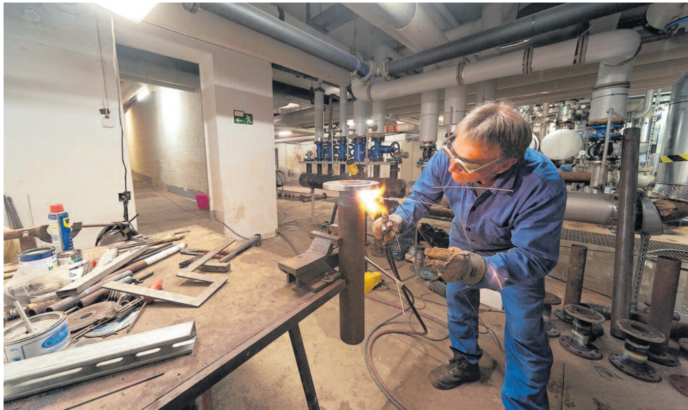
Die Firma Heizungsbau Krause – im Bild Mitarbeiter Dietmar Otto beim Schweißen – ist eine von insgesamt 39 Handwerksfirmen, die an den aktuellen Sanierungen der technischen Anlagen des Stadtbad in Chemnitz beteiligt sind. Foto: Ulf Dahl
