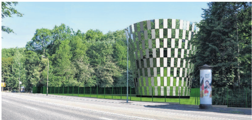
Der Bau eines neuen Trinkwasserspeichers wurde nötig, da der benachbarte einhundert Jahre alte Hochbehälter mit drei Millionen Litern zu groß dimensioniert ist. Montage.: eins
