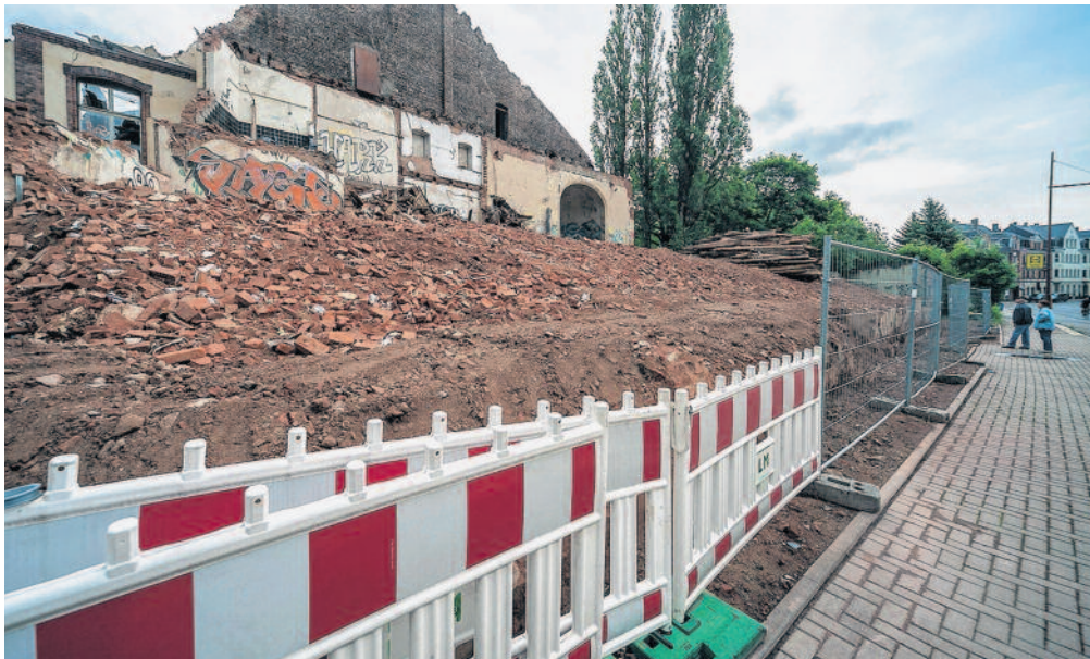
Mit jährlich 400.000 Euro muss die Stadt für Sicherungen und Ersatzvornahmen an maroden Privatgebäuden – wie hier am früheren Marmorpalast – in Vorleistung gehen. Jetzt gibt der Gesetzgeber den Kommunen ein Instrument an die Hand, Eigentümer verfallener Häuser zu deren Abriss zu zwingen. Foto: Ulf Dahl
