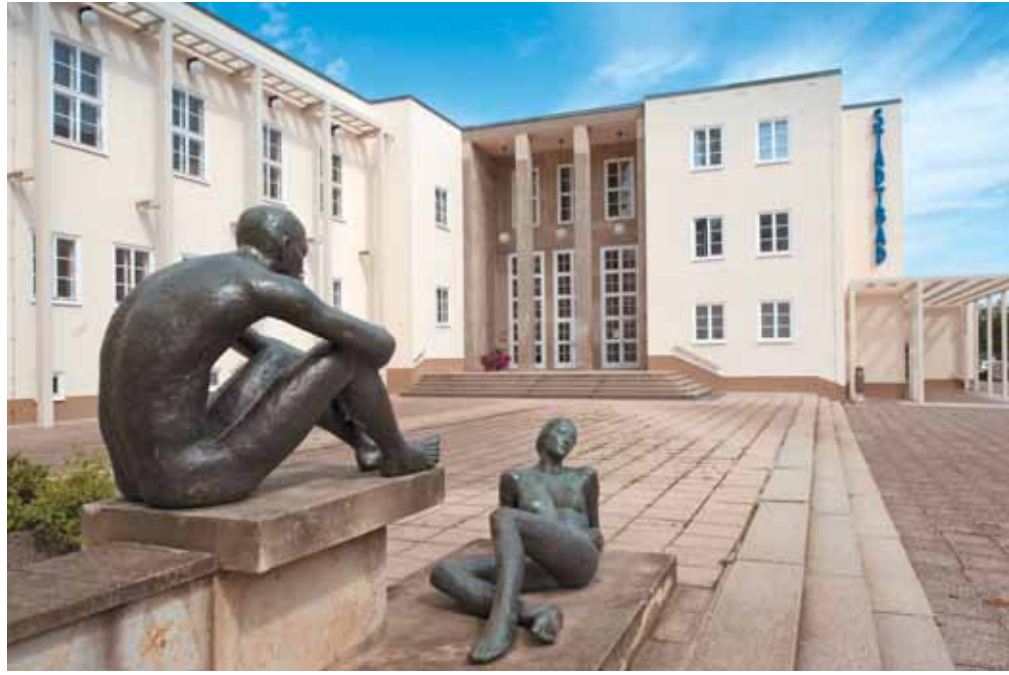
Das markante Hallenbad, erbaut im Jahr 1935, galt einst als modernstes in Europa. Seit einigen Jahren saniert die Stadt an diesem Komplex. Vor allem die Technik wird jetzt auf Vordermann gebracht. Foto: Ulf Dahl
