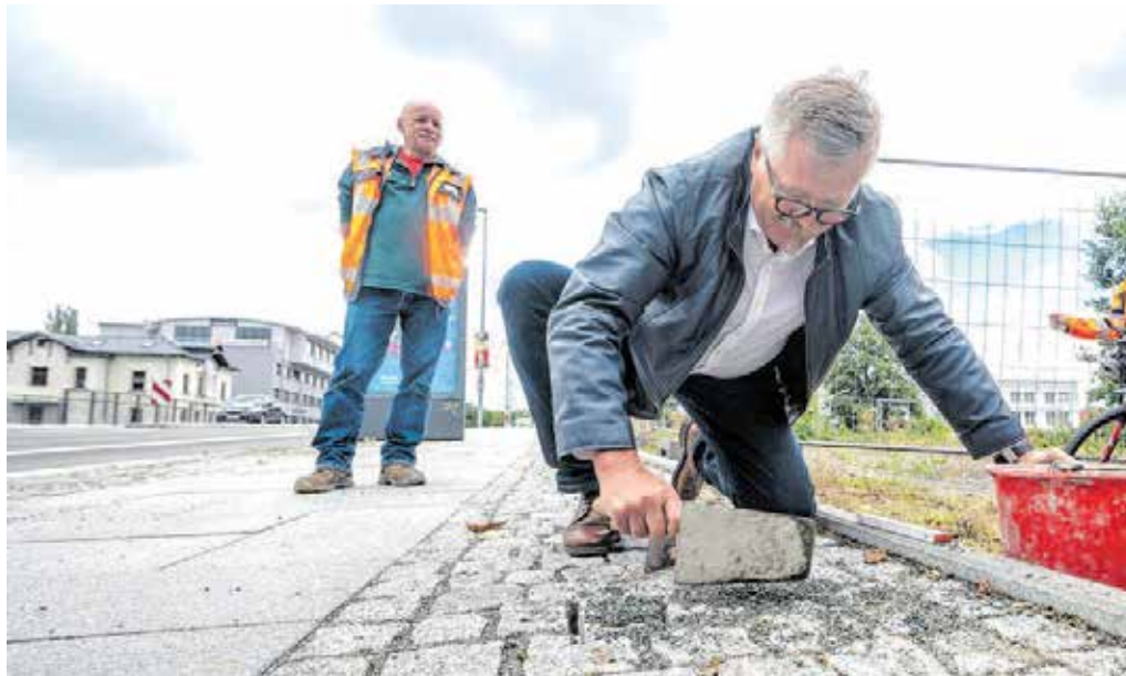
Am 26. August wurde die Brücke Zschopauer Straße zwei Monate früher als geplant freigegeben. Bürgermeister Miko Runkel verlegte den letzten Pflasterstein. Foto: Ralph Kunz
