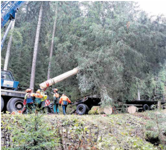
Verladen: Der Kranfahrer von der Firma Kran-Walther und Mitarbeiter der Firma Techno-Farm hievt die 7 Tonnen schwere Fichte auf den Tieflader.
