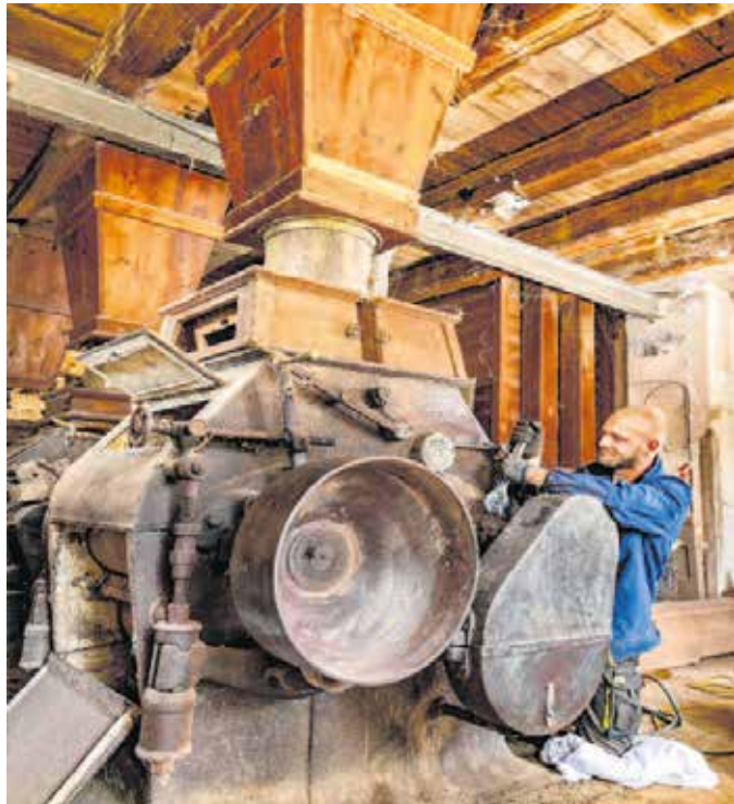
Schlosser Erik Geiermann führt Vorbereitungsarbeiten für den Beginn der Mühlentechnik-Rekonstruktion aus. Foto: Förderverein/Detlev Müller
