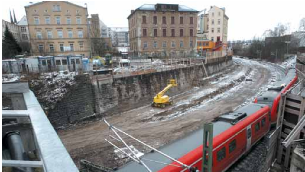
Die alte Brücke am Dresdner Platz weicht einem neuen leistungsfähigen Bauwerk
