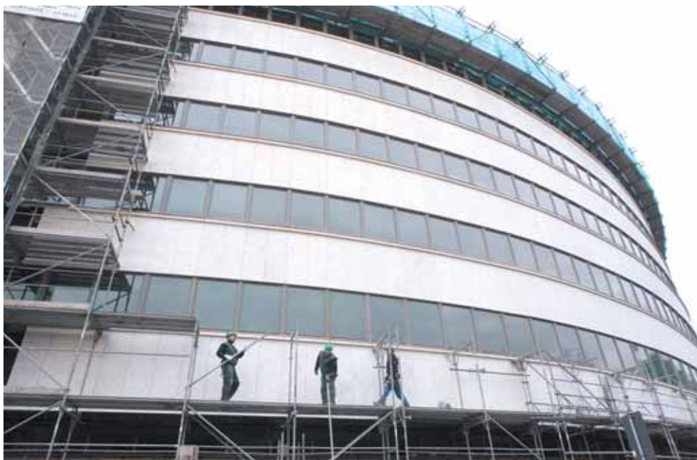
Licht und Schatten – alter Glanz ist zurück, das Gerüst seit Freitag abgebaut.
