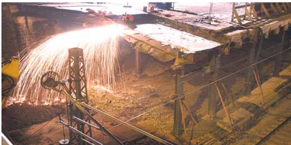
Ein spektakuläres Lichterspiel ist derzeit auf der Baustelle am Dresdner Platz in den Nachtstunden zu beobachten. Foto: Andreas Truxa
