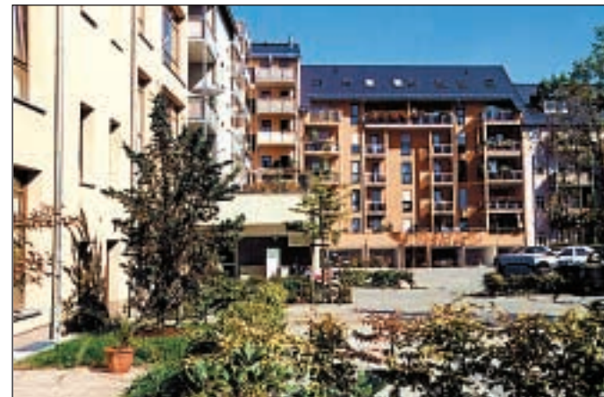
Gelungene Sanierung am Brühl: Innenhof Lerchenstraße.
