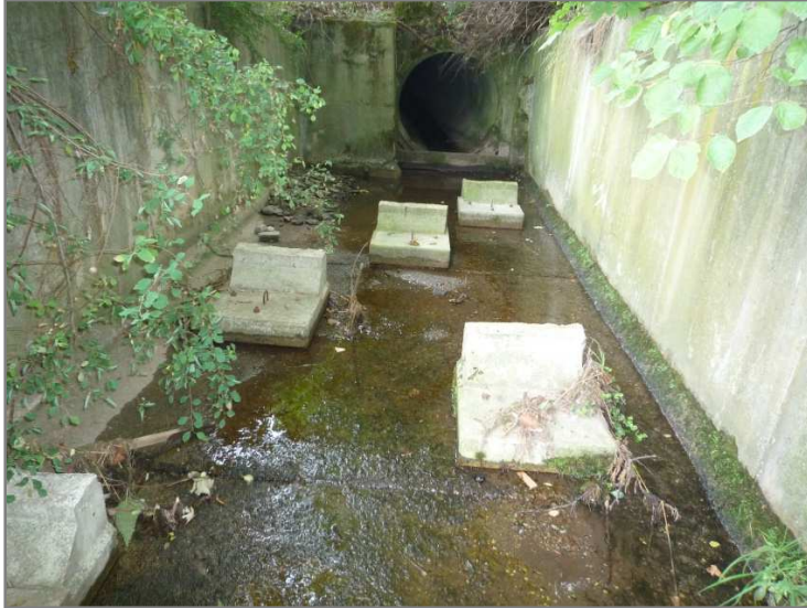
Abbildung 11: Energievernichtungsbauwerk
