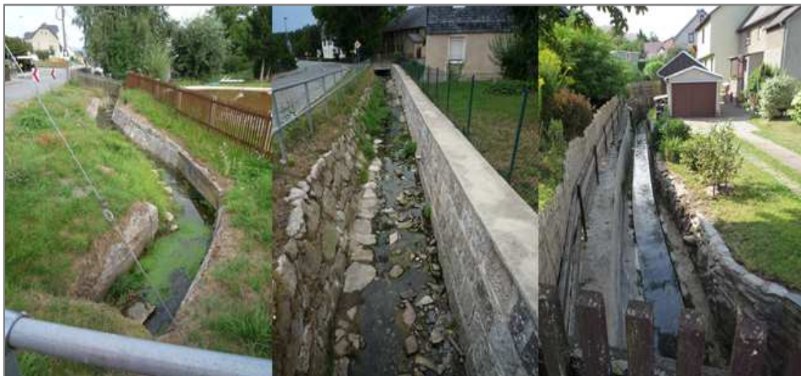
Abbildung 10: Beispiele wasserbaulicher Anlagen am Klaffenbacher Dorfbach
