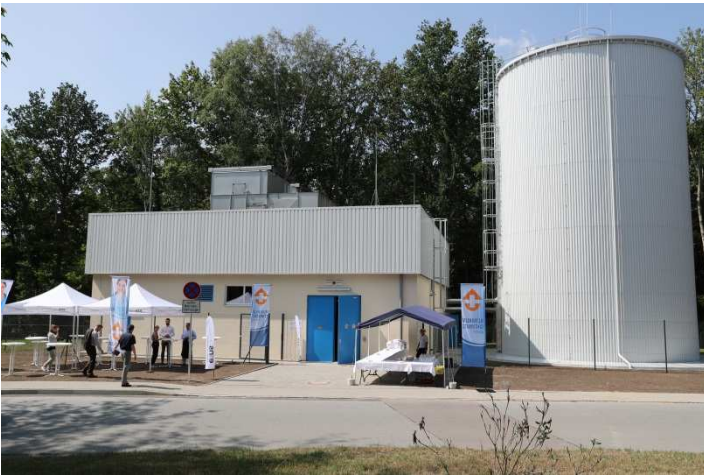
Abb. 33 Kälteversorgung Klinikum Chemnitz
