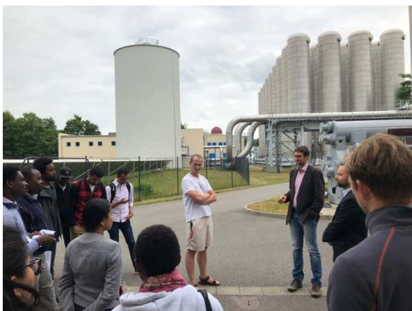
Abb. 42 Besichtigung des Kältespeichers der eins
