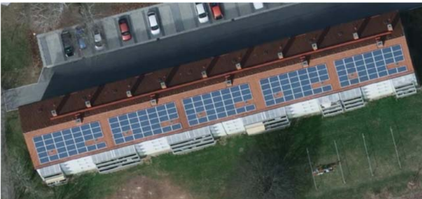
Abb. 34 Photovoltaikanlage, Ladesäule der CSg
