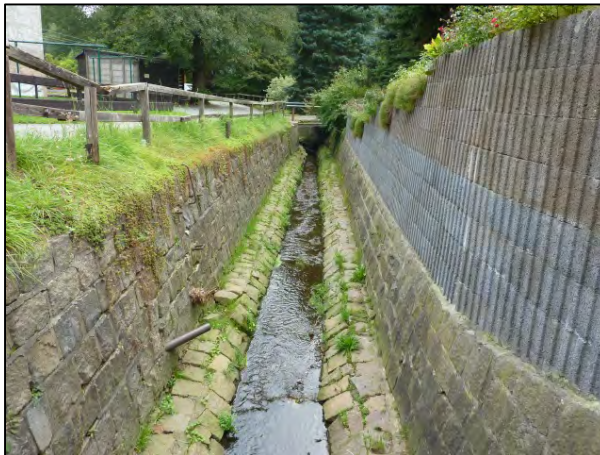
Abb. 7: Ufer- und Sohlverbau bachabwärts auf Höhe der Unteren Hauptstraße 174 (Foto: Umweltamt SV Chemnitz)
