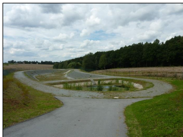
Abb. 19: RRB an der neuen B 174 in Höhe der Hermersdorfer Straße
