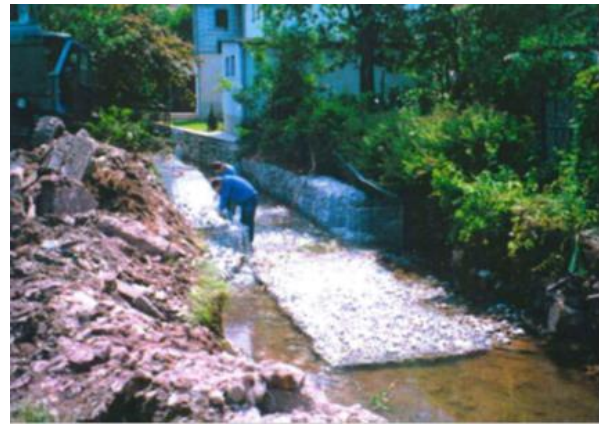
Abb. 8: Ufer- und Sohlverbau am Gablenzbach
