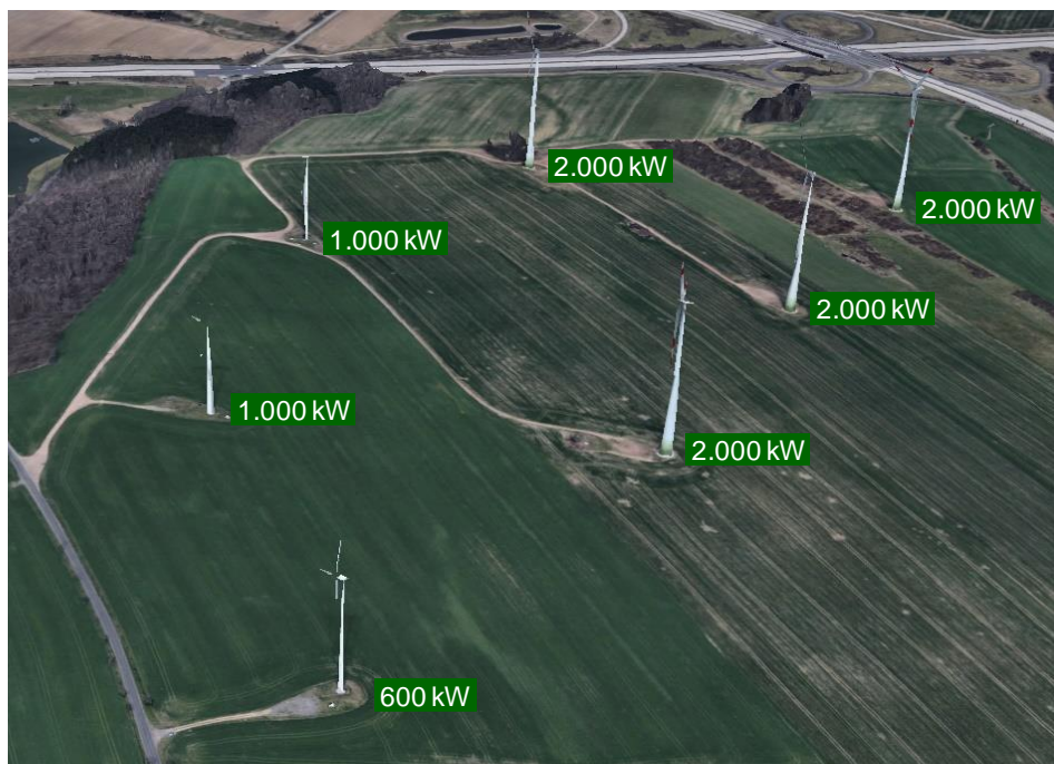
Abbildung 26: Anordnung der WKA des Windparks Chemnitz/Galgenberg mit vier neueren Anlagen (Baujahr 2010, Nennleistung 2.000 kW) und drei älteren Anlagen (Baujahr 2001, Nennleistung 1.000 kW bzw. 600 kW)
