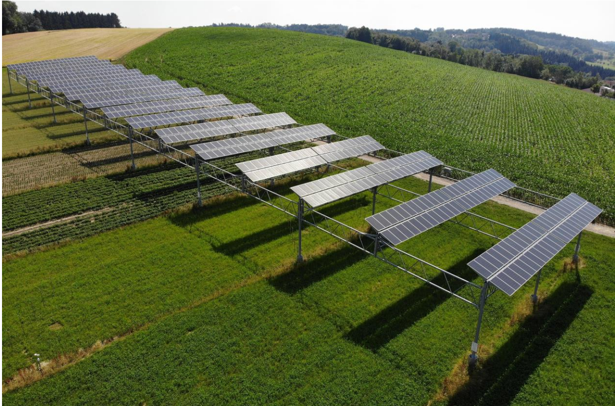
Abbildung 37: Beispiel einer Agro-PV Anlage mit hoher Aufständering der Demeter-Hofgemeinschaft in Heggelbach am Bodensee [67]
