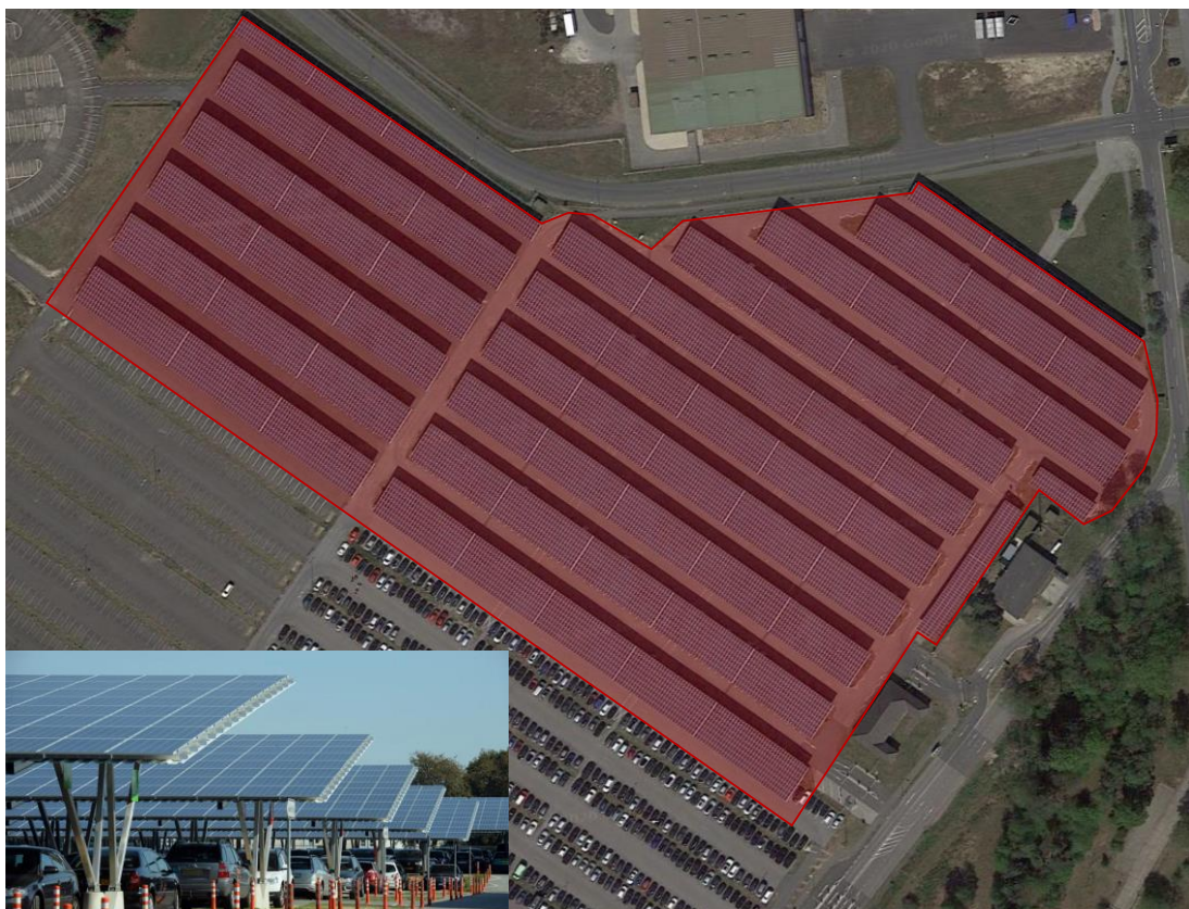
Abbildung 39: Parkplatz P2 am Flughafen Niederrhein in Weeze überdacht durch 66 Solar-Carports mit insgesamt 15.296 PV-Modulen und 4053,44 kWp installierter Leistung [71]
