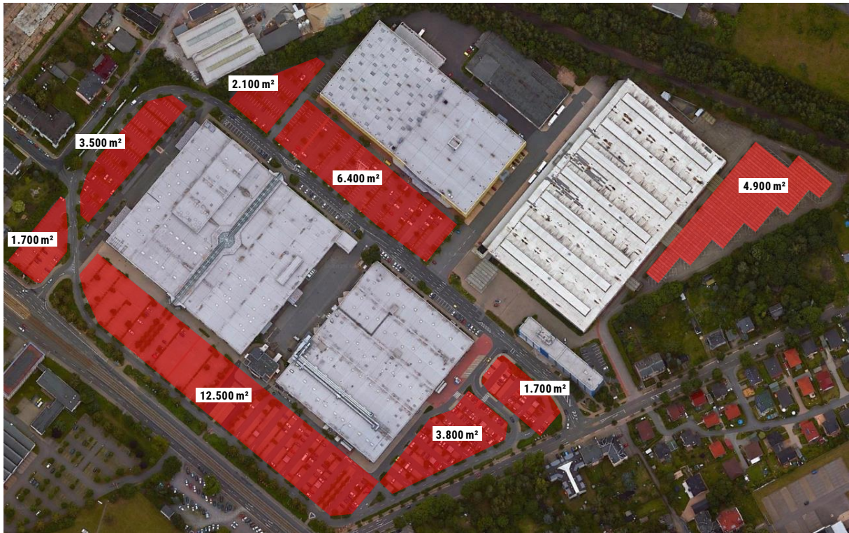
Abbildung 42: Parkflächen des Alt-Chemnitz-Centers mit insgesamt 36.600 m 2 als potenzielle Fläche für die Errichtung von Solar-Carports mit einer möglichen Gesamtleistung von 3,57 MWp [71]
