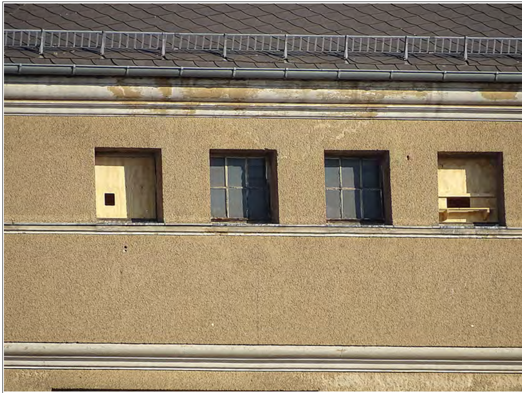
Bild 5: Nistkästen im Nordturm auf dem Hauptgebäude des Spinnereimaschinenbaus
