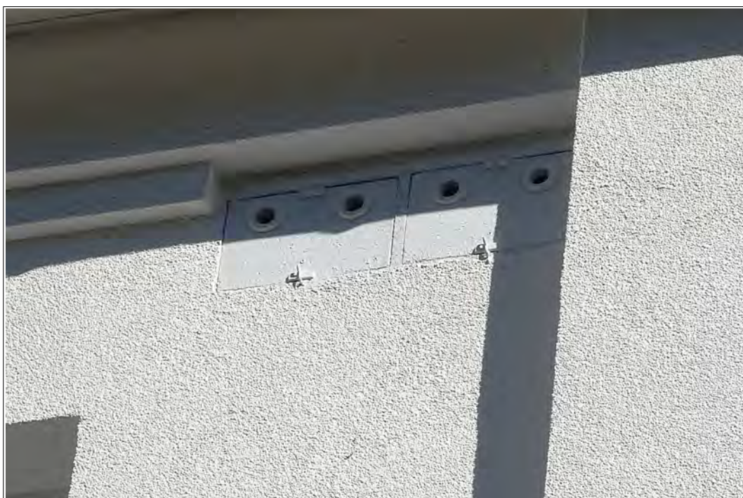
Bild 8: Sperlingskoloniekästen in der renovierten Fassade einer Werkhalle im Spinnereimaschinenbau
