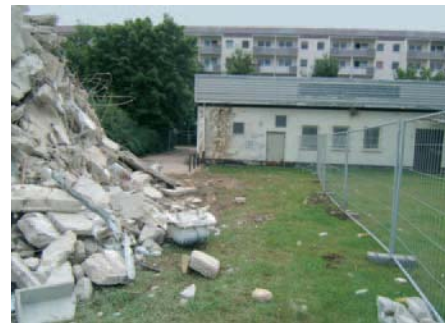
Abbruch im Bereich der Dr.-Salvador-Allende-Str. mit Blick auf den leerstehenden Pavillion
