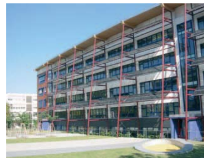
Sanierte Mittelschule "Am Flughafen"
