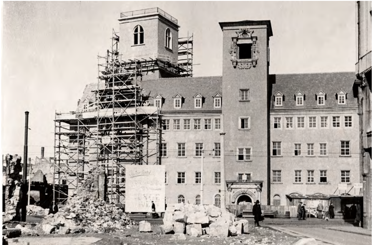
Im Zweiten Weltkrieg war das Alte Rathaus überwiegend zerstört worden. Bis 1949 wurde es gemeinsam mit dem unteren Abschnitt des Hohen Turms wieder aufgebaut. Foto: Kunstsammlungen Chemnitz, Schloßbergmuseum
